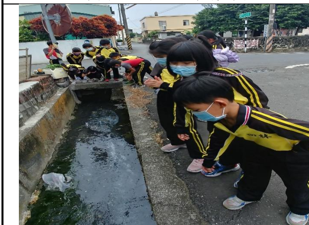
說明：環境教育~髒臭的排水溝
