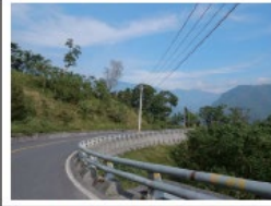
斜坡轉彎道路
